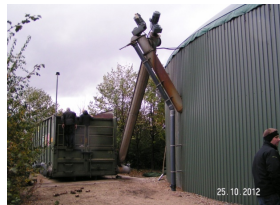
Indføringen af majsensilage og roer med en simpel modtagevogn og et sneglesystem, der fører biomassen ind i reaktoren under væskniveau.
