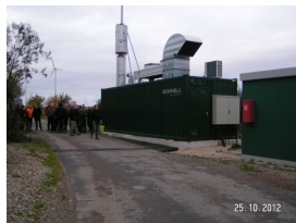
Den nuværende motoreffekt er på ca. 890 kW. Varmen bruges ikke på nuværende tidspunkt.
